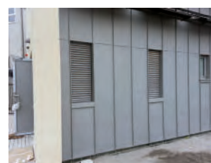
Griglie di ripresa ed espulsione aria
