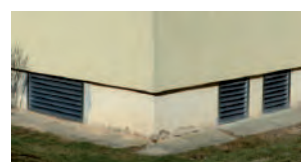
Griglie di ripresa ed espulsione aria
