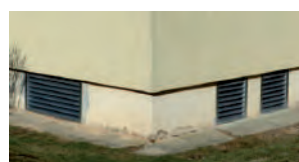
Griglie di ripresa ed espulsione aria
